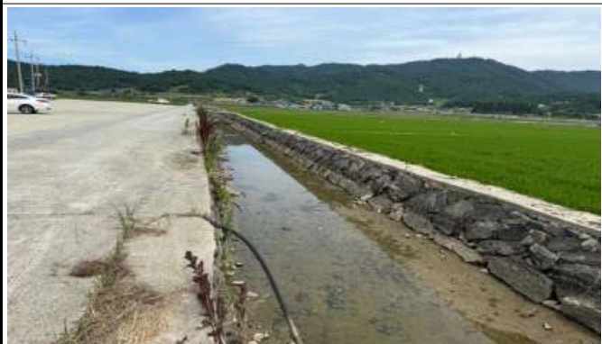
기설 배수로 전경(1)
