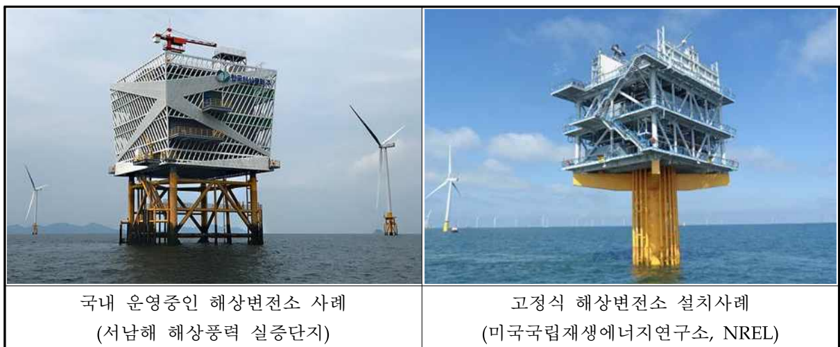
(그림 1.4-4) 해상변전소(OSS) 예시
