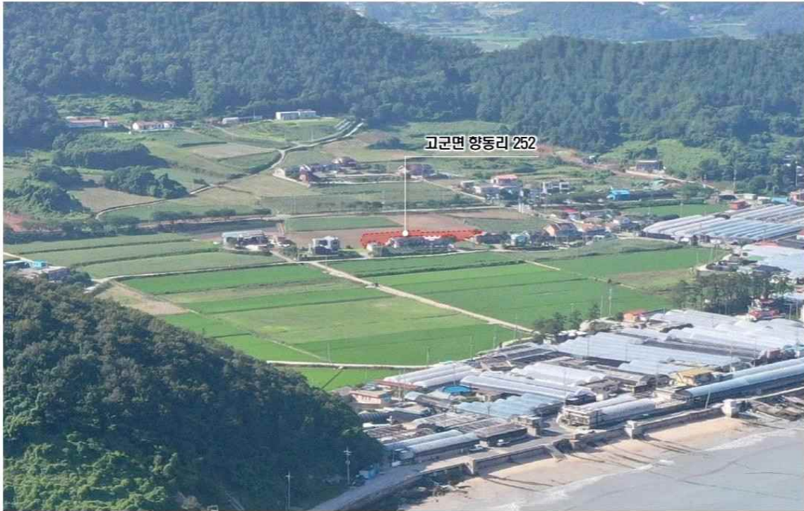
「모사향 어촌뉴딜300사업」 행복드림센터 부지 - 현장사진
