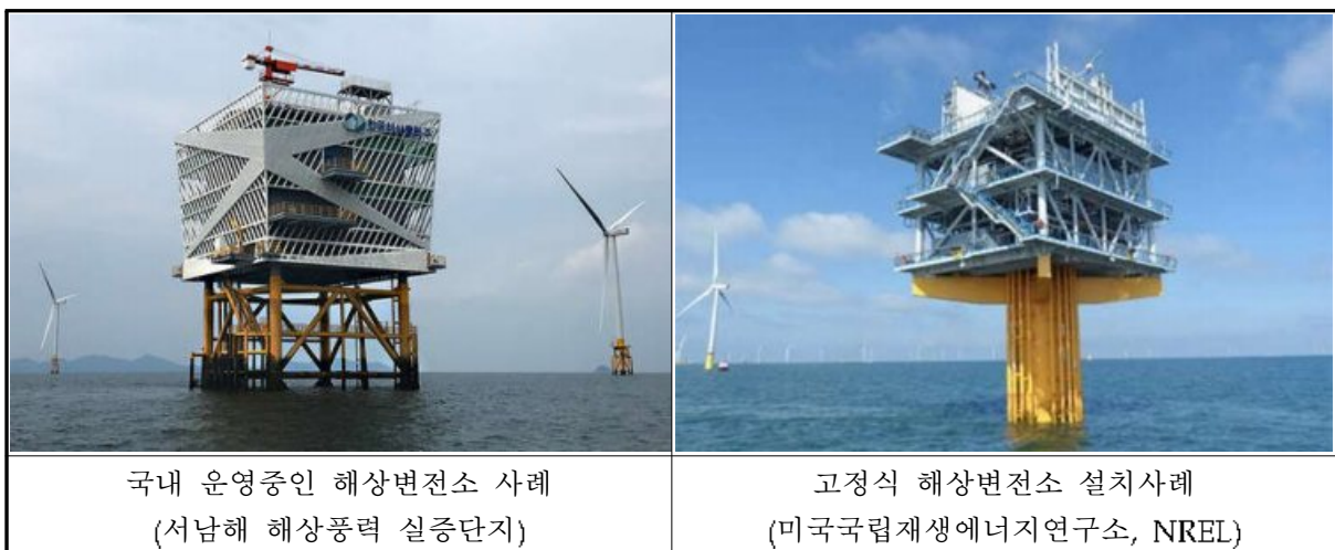
(그림 1.4-4) 해상변전소(OSS) 예시
